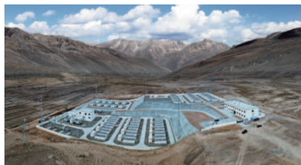
宁夏华严变200MW/400MWh储能电站
